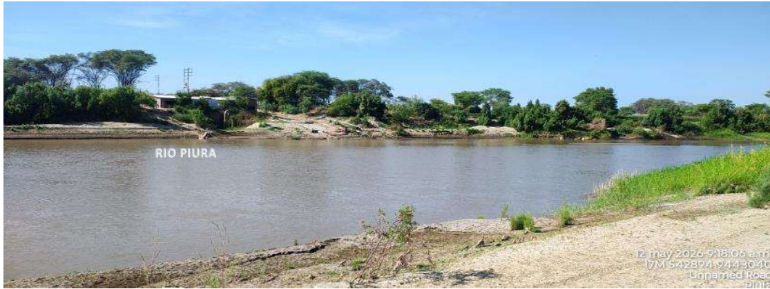
FIGURA N°01: TRAMO CRÍTICO EN EL RIO PIURA, EN EL SECTOR EL PAPAYO, DISTRITO DE TAMBO GRANDE, PROVINCIA DE PIURA - PIURA.
